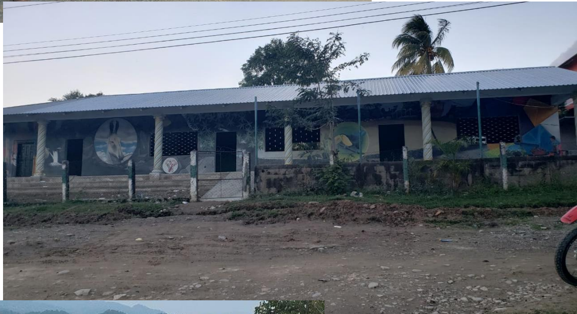
Ilustración 2 y 3 Fachada de la escuela (derecha) Servicios sanitarios para escuela (abajo) Fuente: Acción social de la Iglesia de Dios – CA, Facebook.
